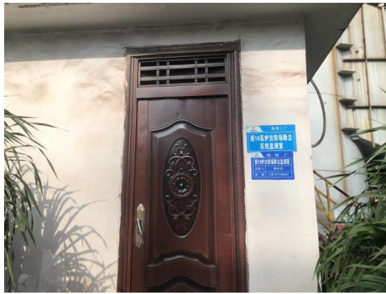
新 1#高炉除铁场除尘在线监测室
