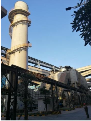
新 1#2#高炉矿槽除尘设施及排气筒
