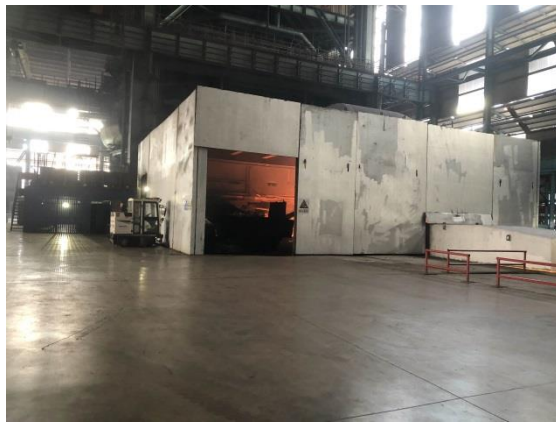
新高炉出铁场收尘
