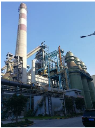
新 1#高炉热风炉排气筒
