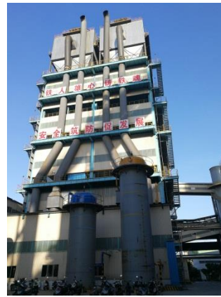
新 1#2#高炉煤粉制备除尘及排气筒（左 1 右 2）
