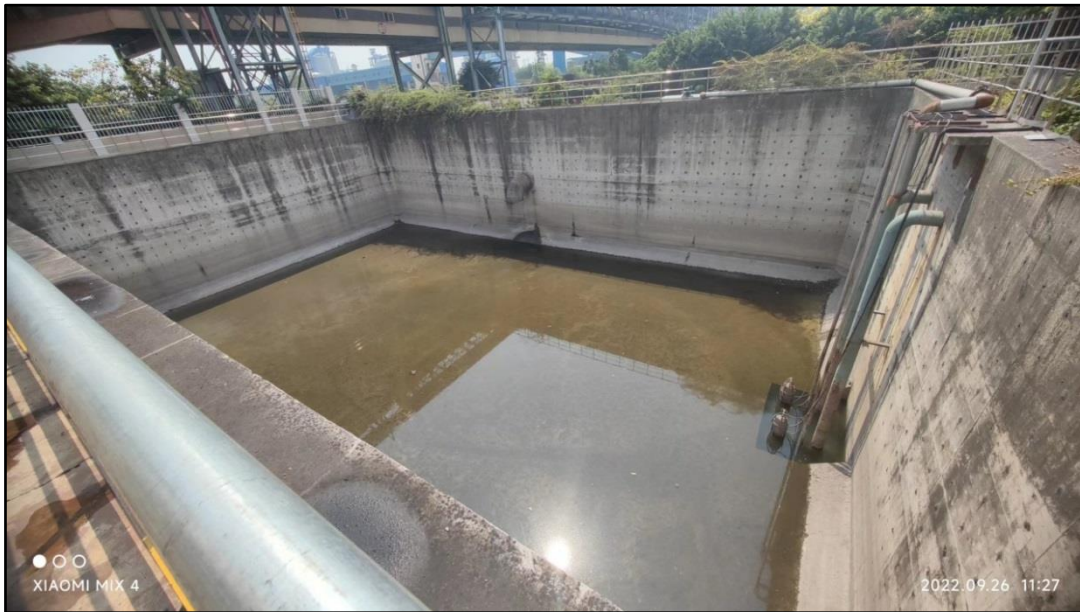
图 4.1-6 4#初期雨水池照片
