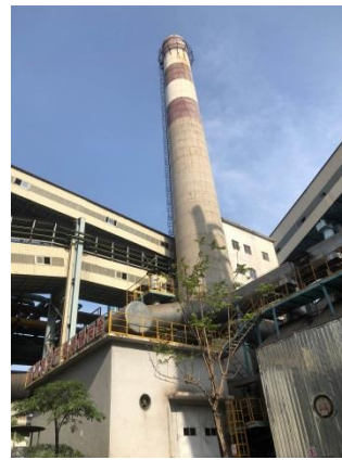
新 2#高炉热风炉排气筒
