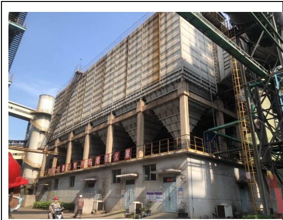
新 2#高炉出铁场除尘设施（含炉顶上料）及排气筒
