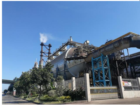
新 1#2#转炉一次烟气除尘设施及排气筒（左 1 右 2）
