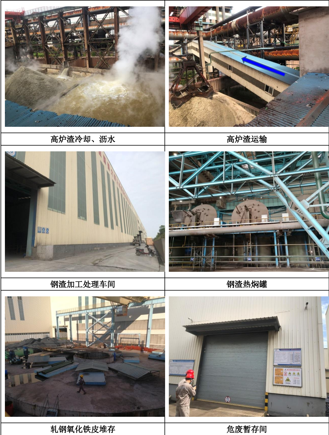
图 4.1-8 项目固废处理设施照片
