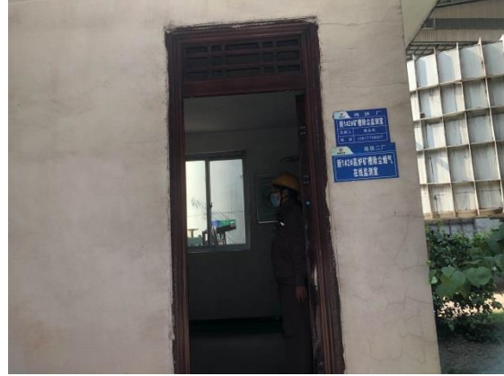
新 1#2#高炉矿槽除尘烟气在线监测室
